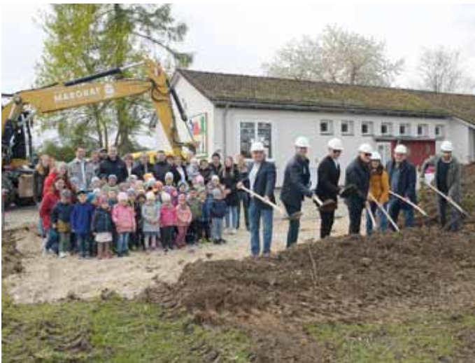
Spatenstich für den Kindergartenneubau in Kaldorf mit den Kindern und Ehrengästen an den Spaten. Darunter Markttrat Willi Bürkl (v. l.) Bürgermeister Andreas Brigl, Pfarrer Johannes Trollmann, Stellvertretender Landrat Bernhard Sammiller, Kindergartenleiterin Daniela Peter, Kreisrat Hubert Hirschbeck und Architekt Andreas Mayer. Text und Foto: Reinhold Gerner
